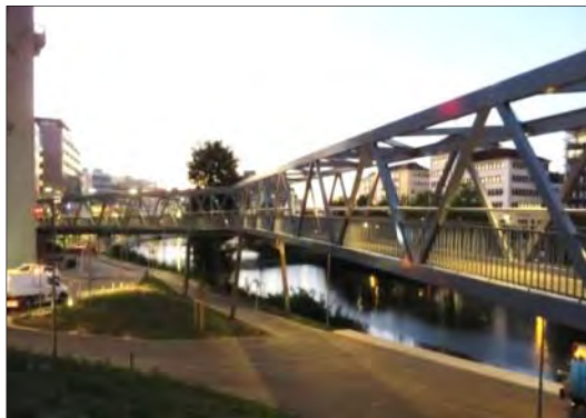
Abbildungen 62: Rampe am Finanzamt, Fuß/Radwegebrücken Osthafen und Congresshalle Quelle: LHS
