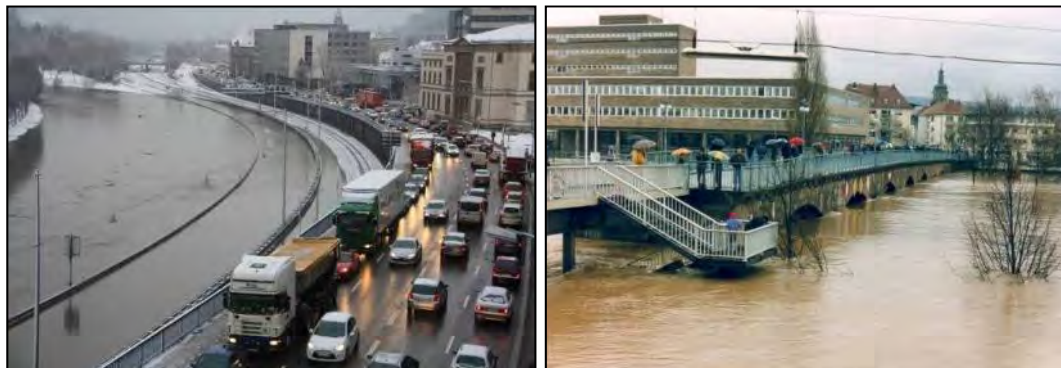
Abbildungen 69: Hochwasser 1993 in Saarbrücken Quelle: LHS
