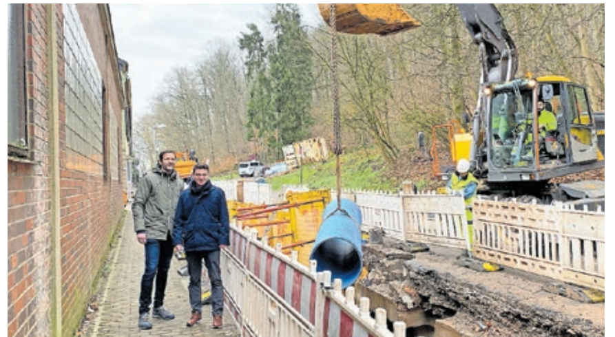
Saarbrückens Baudezernent Patrick Berberich (rechts) und ZKE-Werkleiter Björn Althaus auf der Baustelle in der Straße „Am Engenberg“ in Gersweiler.
