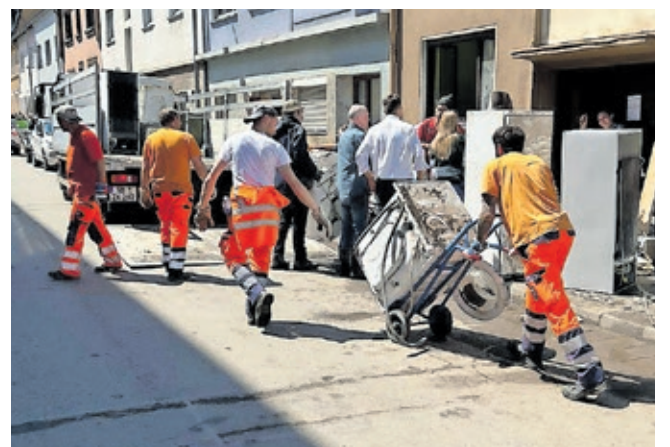
Aufräumarbeiten auf der Rußhütte. Foto: LHS
