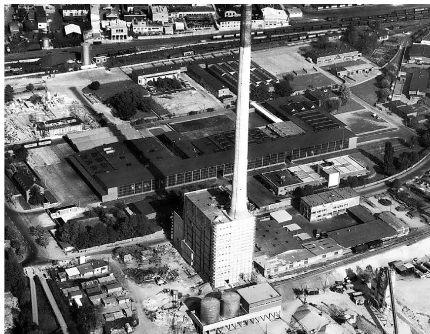
Das Heizwerk an der Römerbrücke kurz nach der Inbetriebnahme in den 60er Jahren. Foto: Archiv Stadtwerke Saarbrücken
