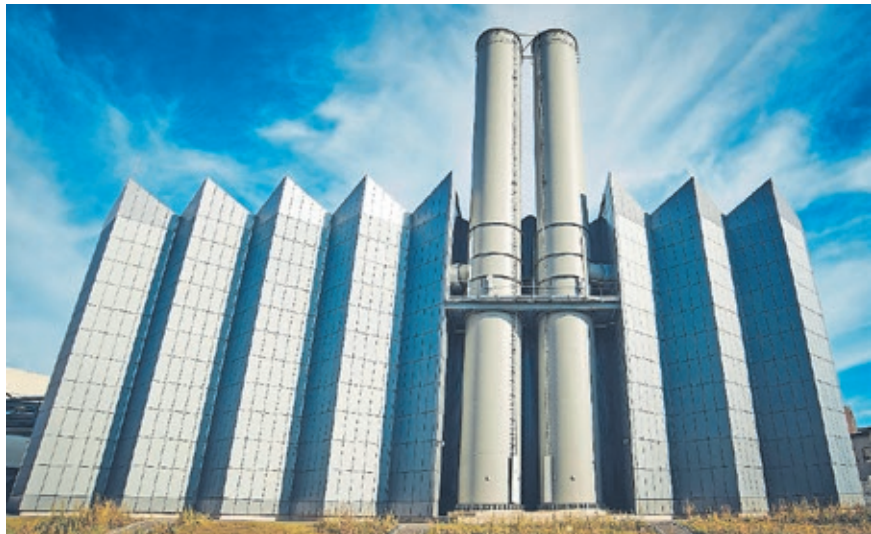
Das Gasmotorenkraftwerk GAMOR ermöglicht eine nachhaltige und umweltschonende Wärmeversorgung in der Landeshauptstadt. Foto: Energie SaarLorLux
